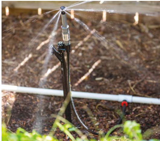
Instalación de la MP-STAKE-PRS40-CV
