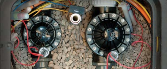
ELECTROVÁLVULA PGV-201 Diámetro de entrada: 2" (50 mm) Altura: 20 cm Longitud: 17 cm Anchura: 13 cm
